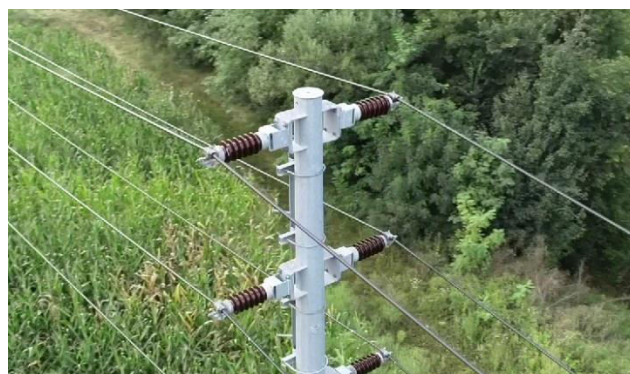
Slika 2: Primer potpornih izolatora za vod tipa R postavljenih horizontalno
